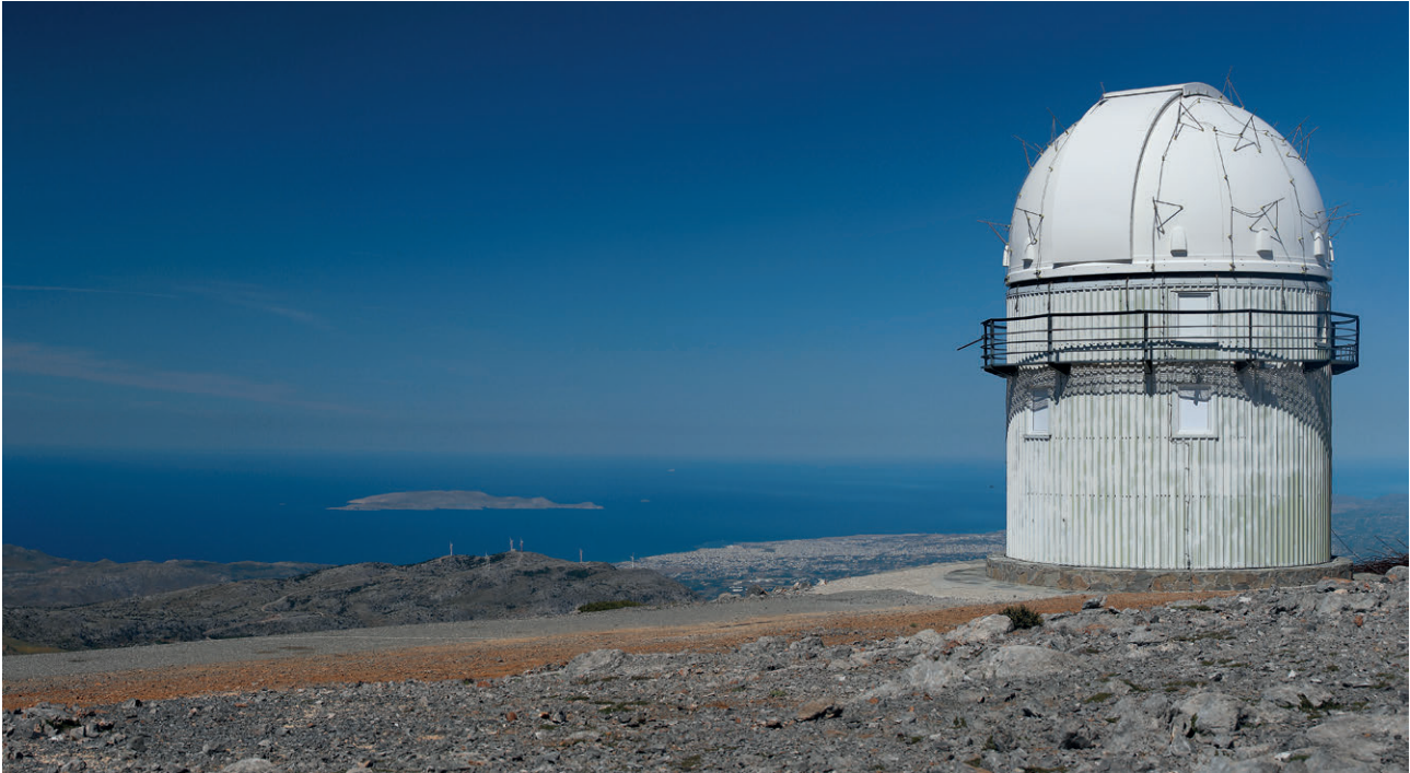
ΕΙΚΟΝΑ 8.8 Το μεταλλικό κτίριο που στεγάζει το τηλεσκόπιο διαμέτρου 1,3 μέτρων.
