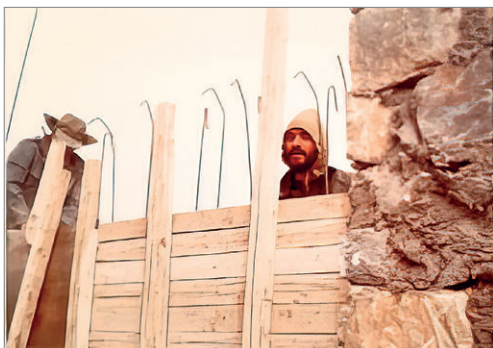
ΕΙΚΟΝΑ 8.4 Νοέμβριος 1985. Κάτοικοι των Ανωγείων χτίζουν το πρώτο, πέτρινο, κτίριο του Αστεροσκοπείου μέσα στις δύσκολες συνθήκες του Ψηλορείτη.
